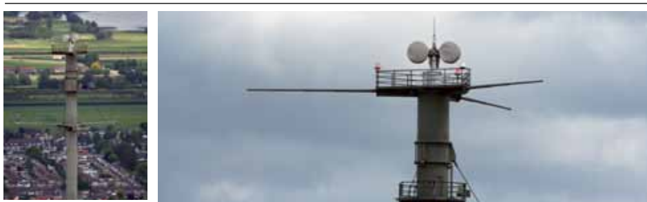
Figuur 2.14 Voorbeeld van X-bandradar op de mast in Cabauw (IDRA project)
